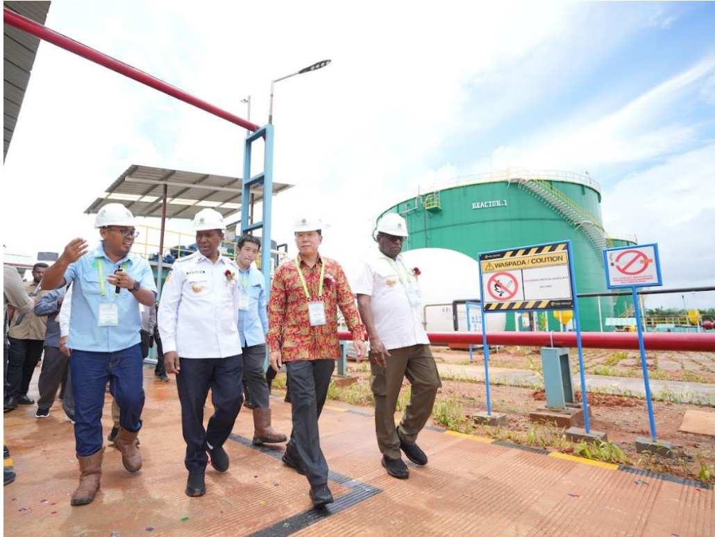
Foto: Teknisi Biogas sedang menjelaskan Pembangkit Listrik Tenaga Biogas dan fasilitas Compressed Biomethane Gas yang ada di TSE Group, Merauke, Papua Selatan.
